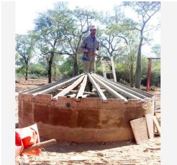
Figura 19. Aljibe construido en el chaco paraguayo
