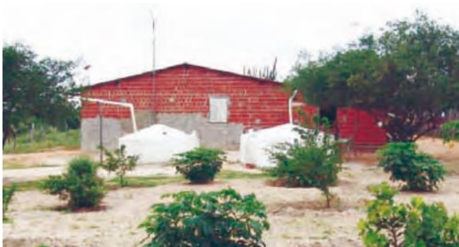
Figura 28. Recolección y almacenamiento de agua a través de aljibes
