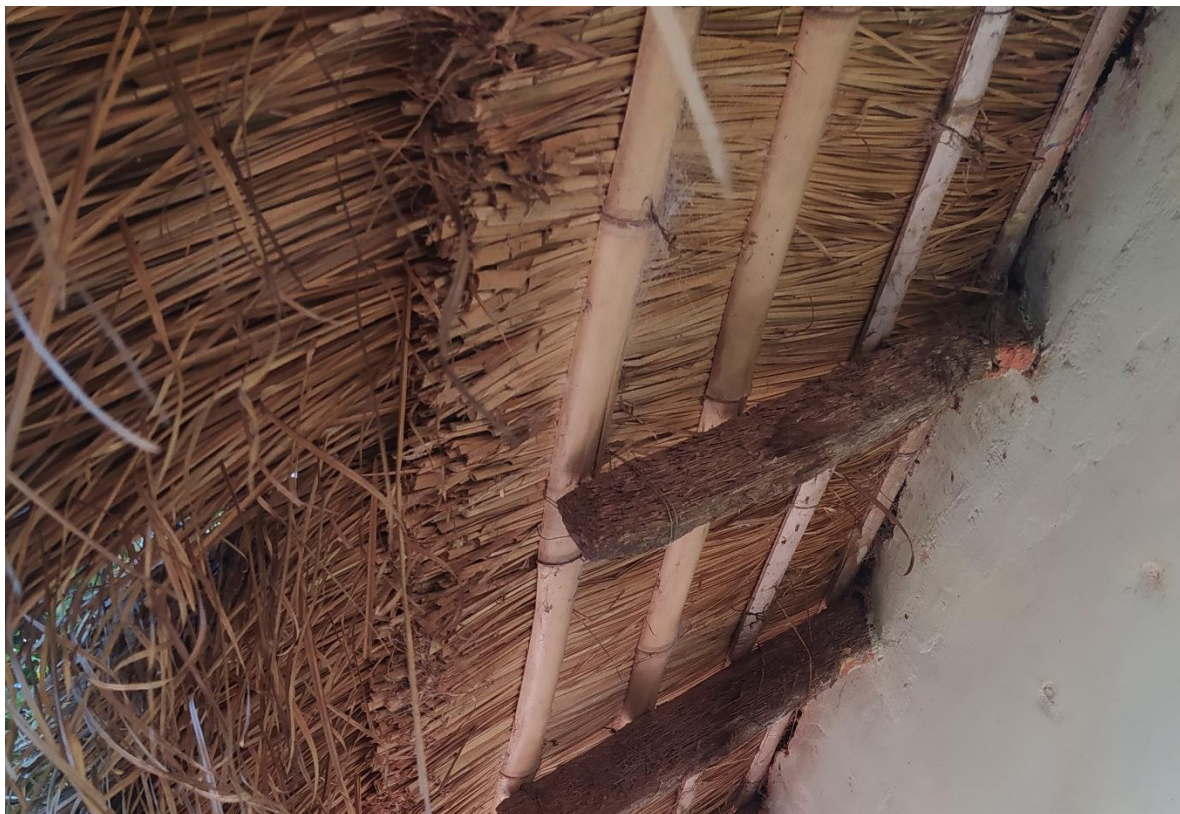
Figura 11. Características del techo de la Vivienda rural 1
