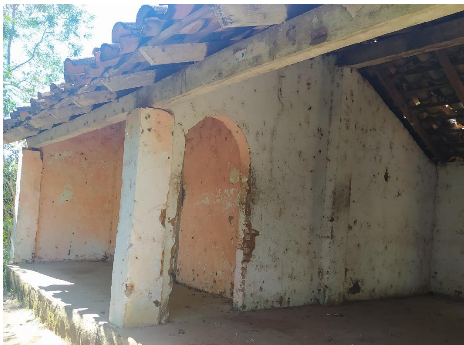
Figura 15. Vista lateral de uno de los cuartos de la vivienda 2
