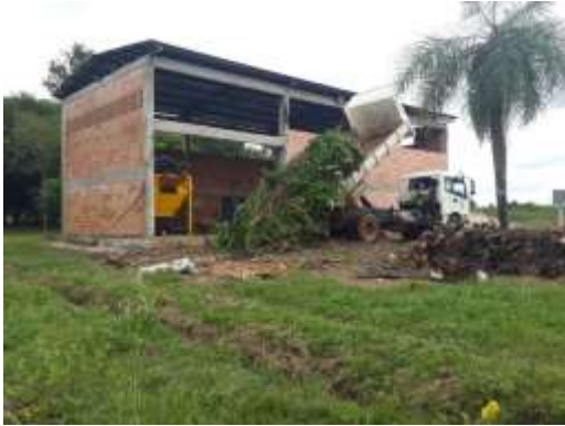
Descarga del camión
