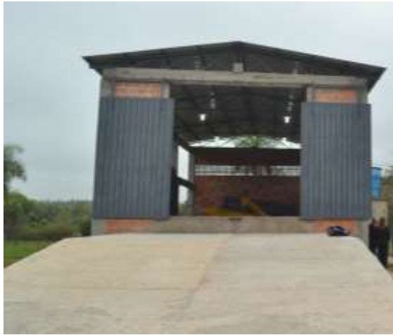
Rampa de acceso y tinglado
