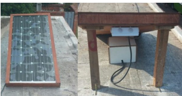
Figura 11. Instalación del panel solar.
