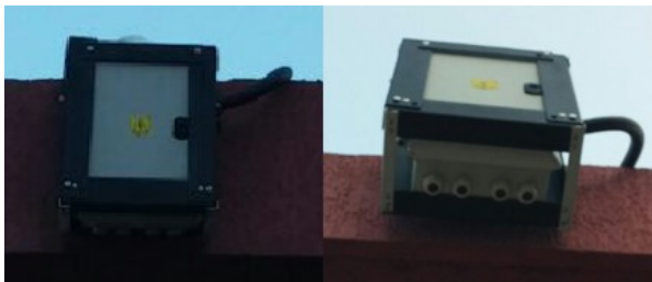
Figura 10. Instalación del sistema medidor.
