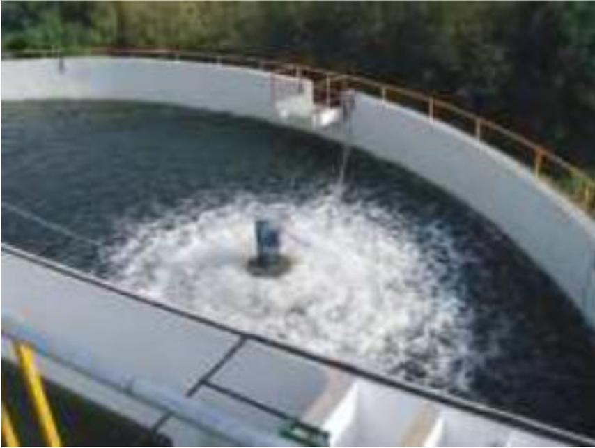
Reactor de Lodos Activados con Aireador Flotante
