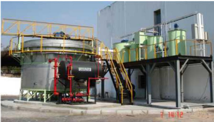
Equipo de Flotación por Aire Disuelto - DAF y Sistema de Pre-Tratamiento Físico-Químico
