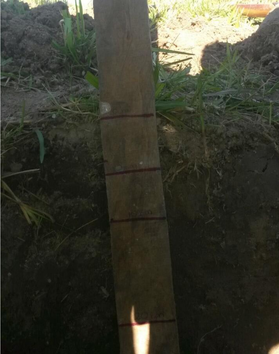
Foto 1. Minicalicata construida para el muestreo de suelos.
