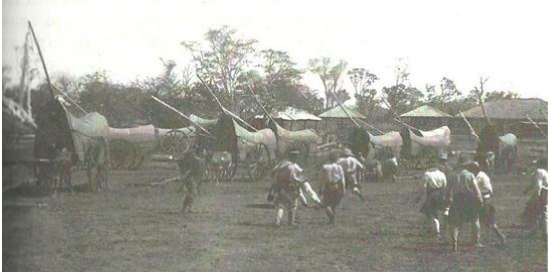
Figura 18. Caravanas de carretas que transportaban la yerba mate al puerto de Villa Real.
