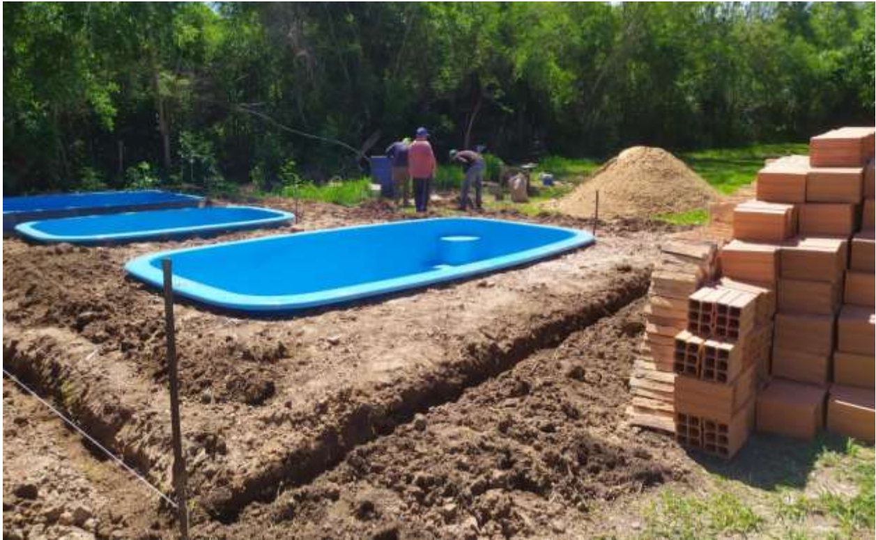
Instalación de las piletas de tratamiento en el INCAN
