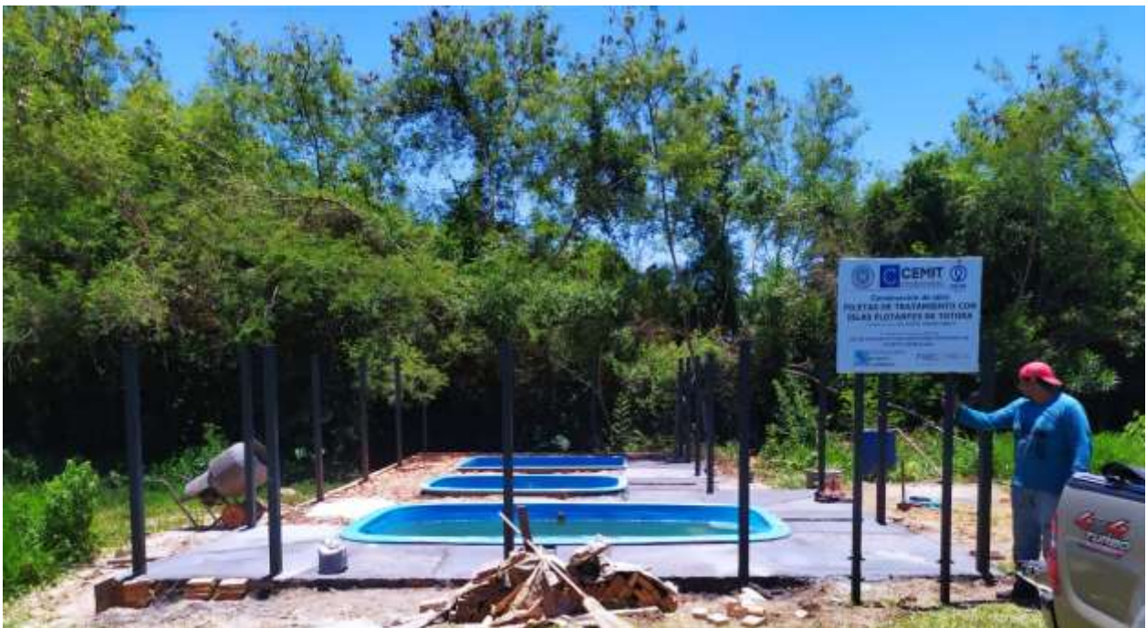
Colocación del cercado de protección
