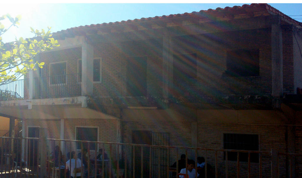
Fotografía 3. Aulas en construcción del Colegio Nacional San Francisco de Asís
