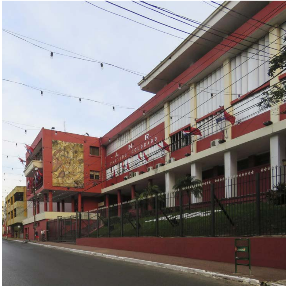
Figura 2: Vista actual del edificio de la ANR en Asunción proyecto de los arquitectos Tomás Romero Pereira, Homero Duarte y José Luis Escobar inaugurado en 1951. El edificio es uno de los iconos de la arquitectura moderna de Paraguay. Fotografía de Mauricio Paiva. Archivo del CIDI FADA UNA.
