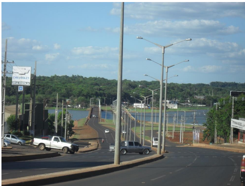
Figura 20: Cabecera del puente Santa María en el acceso a la ciudad sobre la ruta 6 ta
