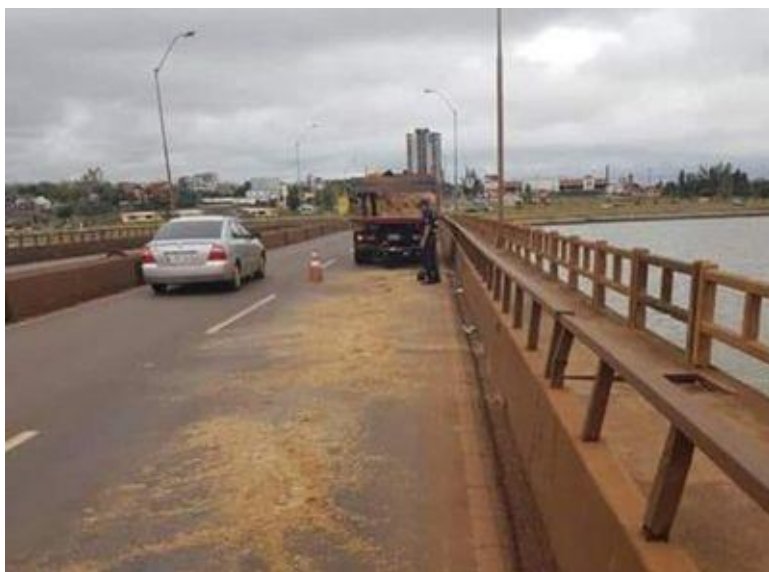
Figura 7: Puente sobre el arroyo Mboi Ka´e
