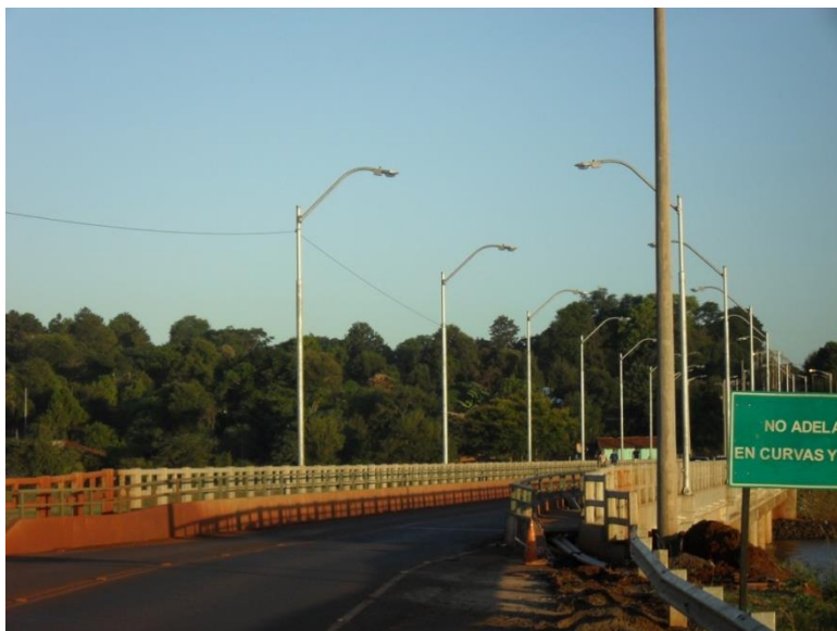
Figura 11: Cabecera del puente Yaku Paso
