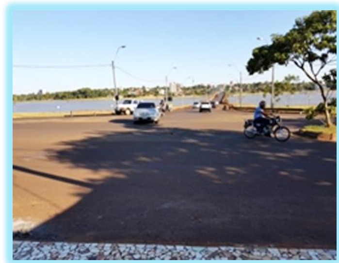
Figura 10: Cabecera del puente del barrio San Pedro frente a la escalinata
