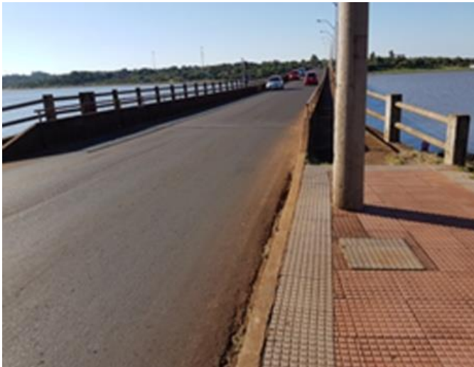
Figura 9: Detalle de la cabecera del puente del barrio San Pedro
