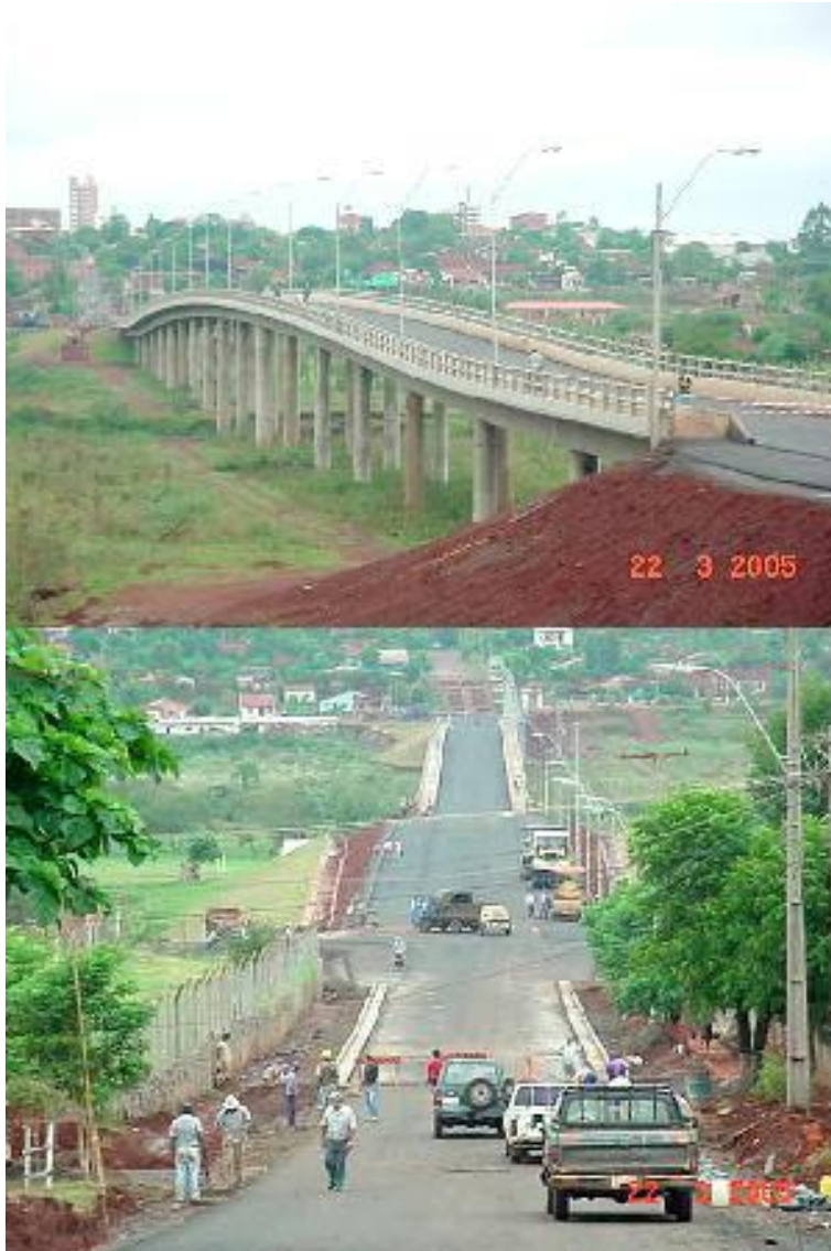
Figura 12: Puente Yaku Paso periodo de obra
